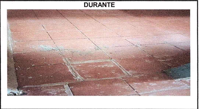
Foto 2: Empezo el proceso de mejoramiento del piso en el aula 1.
